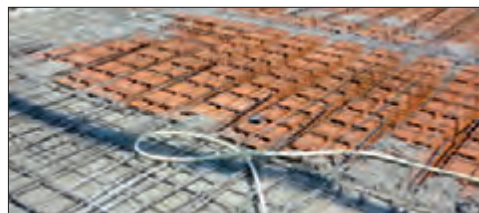
Solaio in laterocemento gettato in opera
